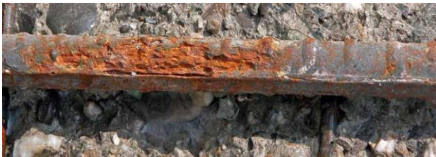
Hình 1.1 Thép bị ăn mòn tạo gỉ do tác động của môi trường.
