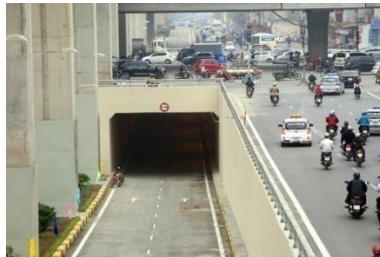
Hình 1 Hầm chui Thanh Xuân gia cố nền bằng trụ đất xi măng
